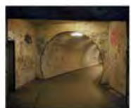
Bicycle road, Széchenyi Bridge Kerékpárút, Széchenyi-Lánchíd
