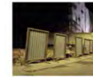
Demolition, Király Street Bontási terület, Király utca
